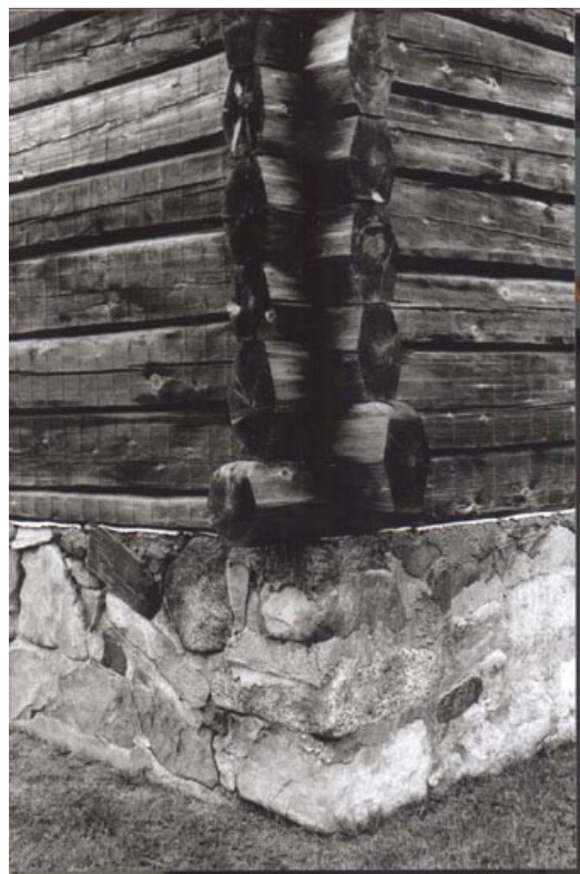
De sexkantiga knutarna bildar sammanhängande hörnkedjor och väggarna är täljda med svagt utstående linjer, som på 1600-talets kapell. På grund av rötskador är knutarna numera inklädda. Foto Anna Elmén Berg 1992.
