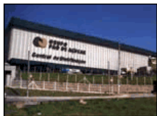
Central de Distribuição
