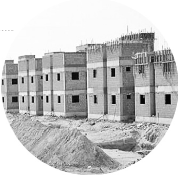
المشاريع السكنية تحت الإنشاء بدون ربطها المكاني والاجتماعي بسياقها المباشر.
