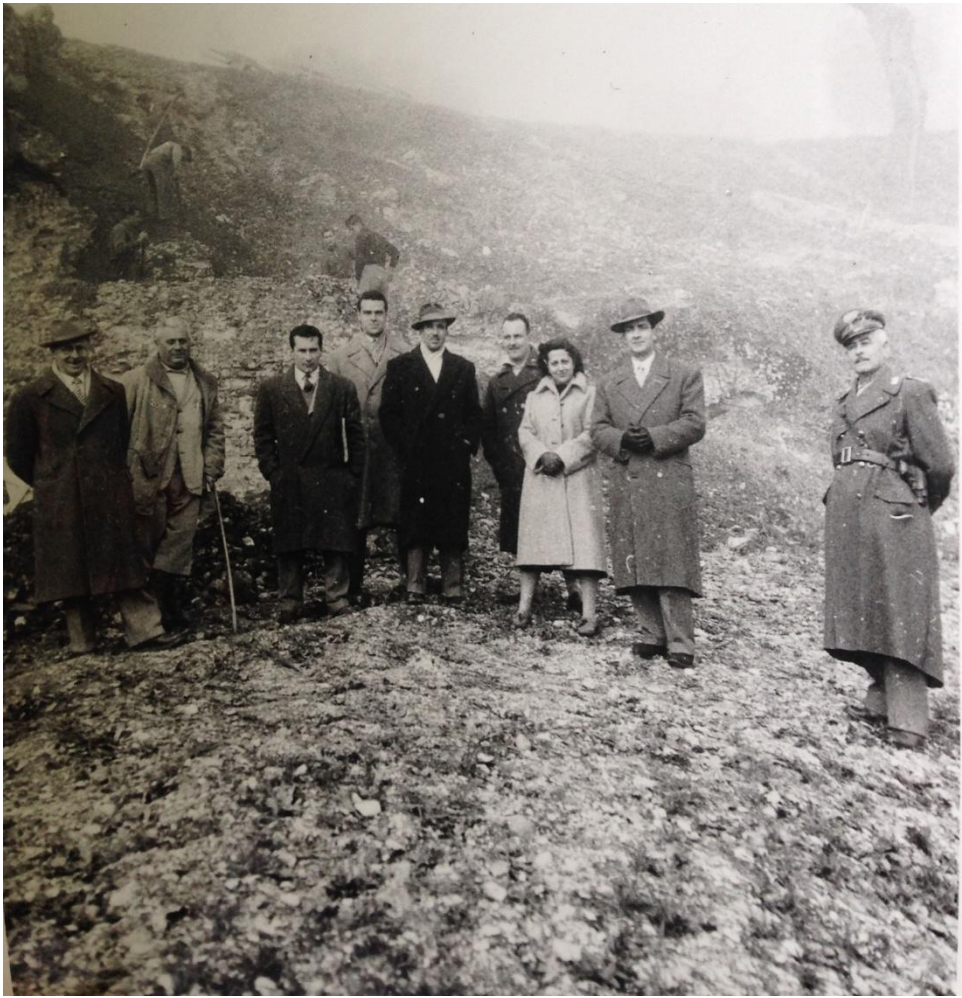
Fig. 1 - Urbisaglia . Inizio dei lavori al teatro. 25 Febbraio 1952 (AFS, neg. 1026/201602)
