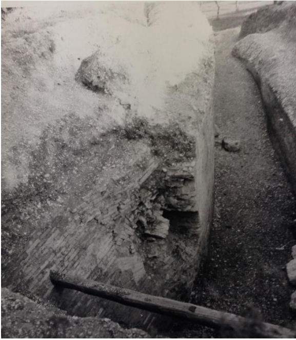
Fig. 10 – Urbisaglia. Teatro. Lavori (1953) (AFS, neg. 1363/201919)
