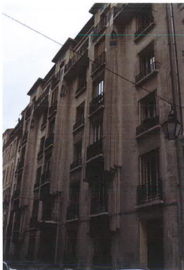
5 Rue Gimelli (immeuble Arts Déco) Photo Service Etudes et Planification - Ville de Toulon
