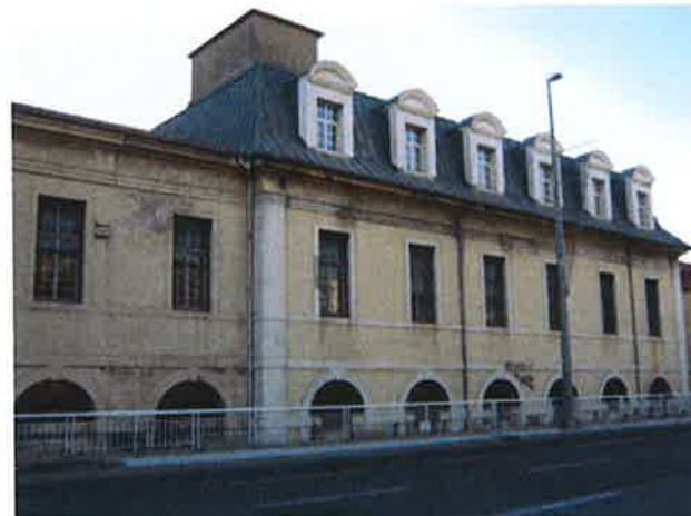
La Corderie Photo Service Etudes et Planification - Ville de Toulon
