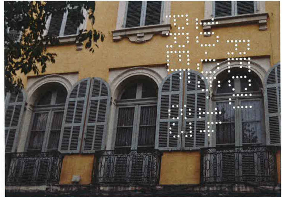
Baies de l'immeuble Sigaud
