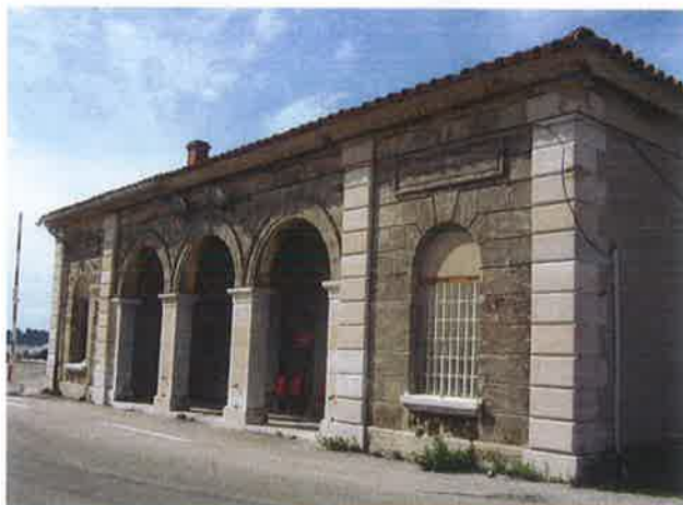
Poste de garde de Missiessy Photo Service Etudes et Planification - Ville de Toulon
