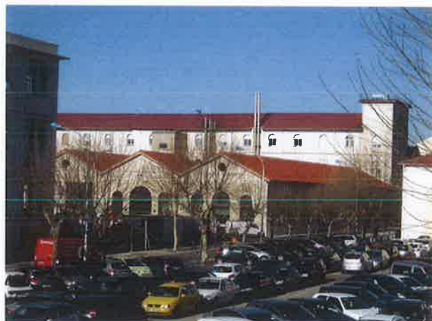
DN16 - DN17 Photo Service Etudes et Planification - Ville de Toulon
