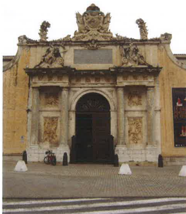
Porte principale de l'Arsenal
