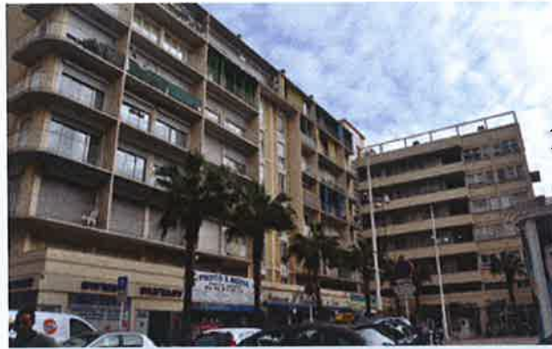
Le Gambetta (reconstruction après-guerre) Photo Service Etudes et Planification - Ville de Toulon
