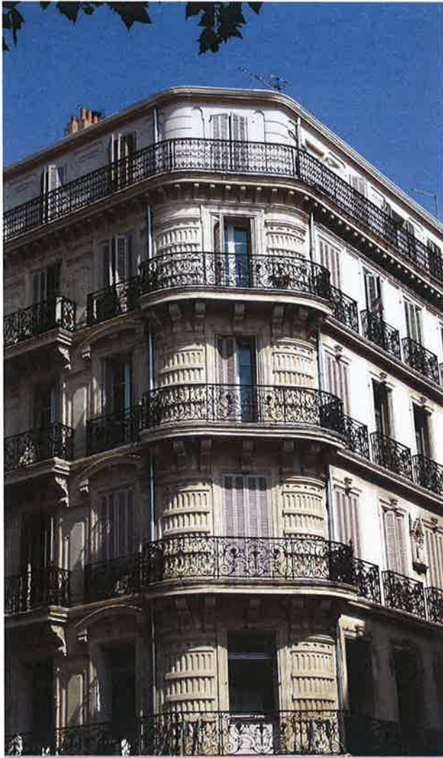
Angle boulevard de Strasbourg -1 rue d'Antrechaus
