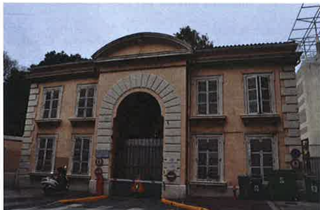
Pavillon d'entrée de l'Hôpital Chalucet Photo Service Etudes et Planification Ville de Toulon
