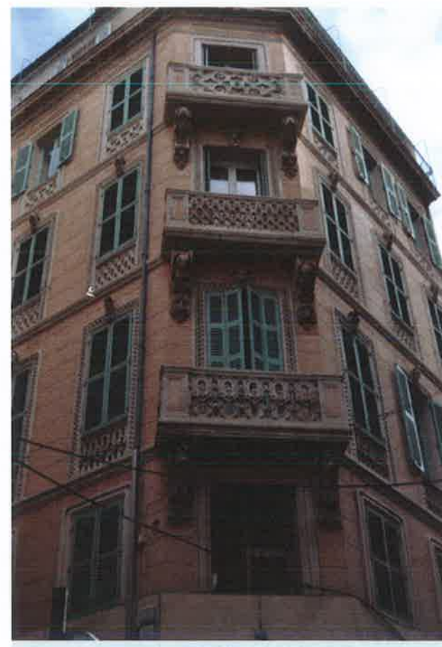
Angle Rue Seillon Rue Daumas (immeuble atypique XIXème) Photo Service Etudes et Planification - Ville de Toulon
