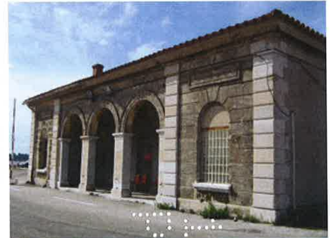
Poste de garde de Missiessy Photo Service Etudes et Planification Ville de Toulon
