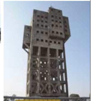
志免町竖坑槽
