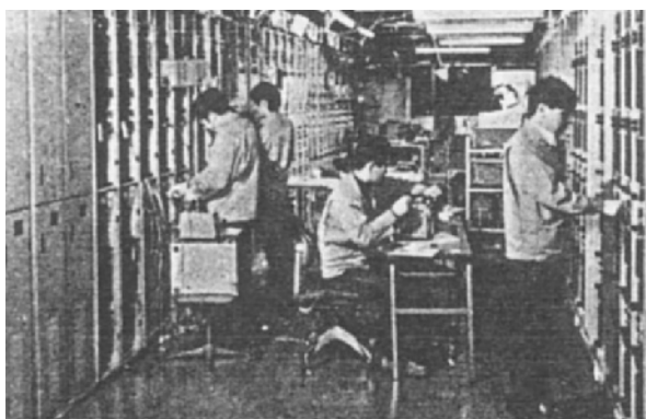
図4.5 都市災害対策用無線電話の基地局試験作業（1967年） (6)
