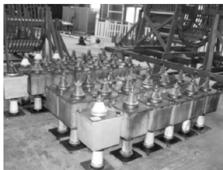
図3.8 コンデンサーとコイルによる共振で長波を発生(電気興業社所蔵)
