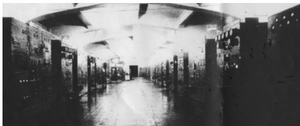
図3.9 小山送信所送信機室 （両側へぎっしり短波送信機） (6)
