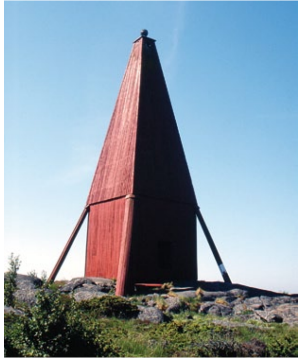
Härkmeren tunnusmajakka, rungon ulkopuolella erottuvat vinoet estävät merimerkin kaatumisen kovalla tuulella.
