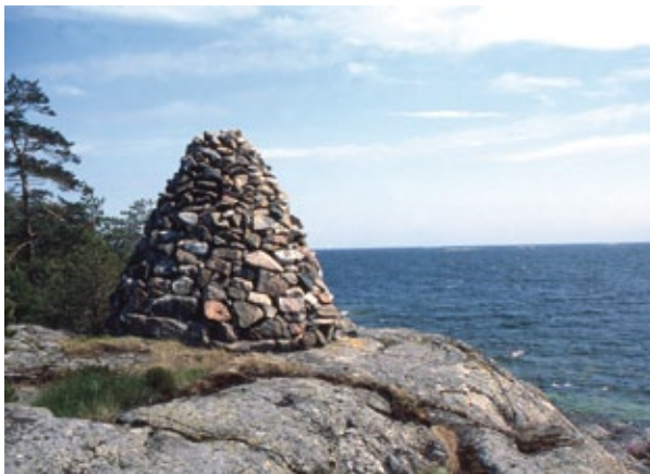
Päivskärin kummeli Inkoon ulkosaaristossa on rakennettu vuonna 1888. Sen huippumerkkinä ollut puusalko on kadonnut, myös valkoinen maalaus on kulunut pois.
