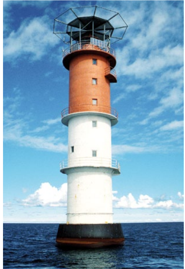
Nahkiaisen majakan huipussa on helikopteritasanne huoltolentoja varten.
