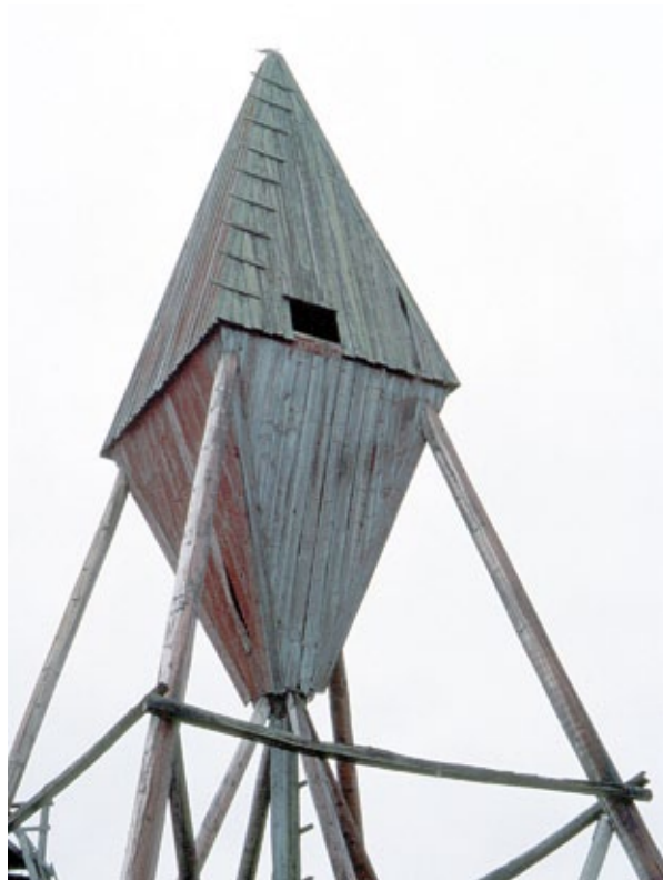
Svetgrundin sauvarakenteisen merimerkin runko koostuu keskuspiirun ympärille ryhmittyvistä vinotuista. Yläosan lautaverhoilu muodostaa kauas näkyvän rombikuivon.
