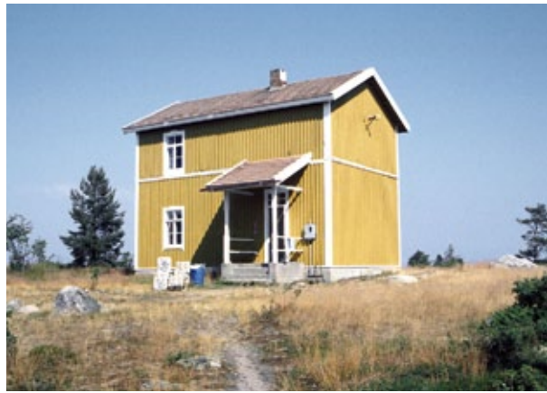
Ohtakarin kaksikerroksinen luotsivartiotupa sijaitsee saaren kor- keimmalla kohdalla.
