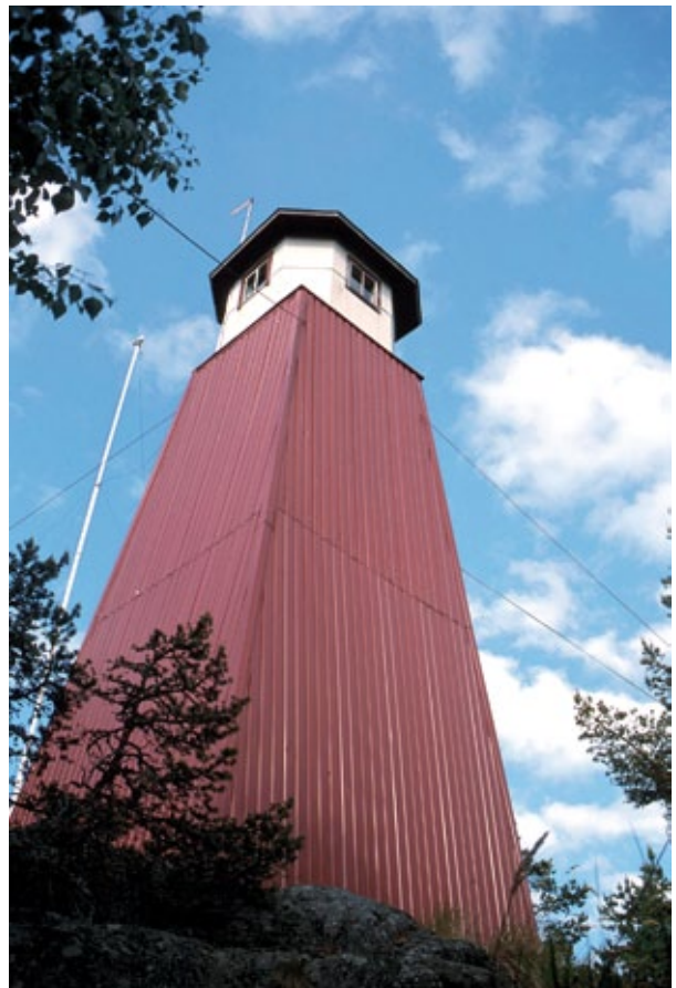
Höggklubbin luotsien tähystystorni. Painijamestari luotsi Göran Skogman kulki portaikkojen kaiteilla pelkkien käsivoimiensa varassa.
