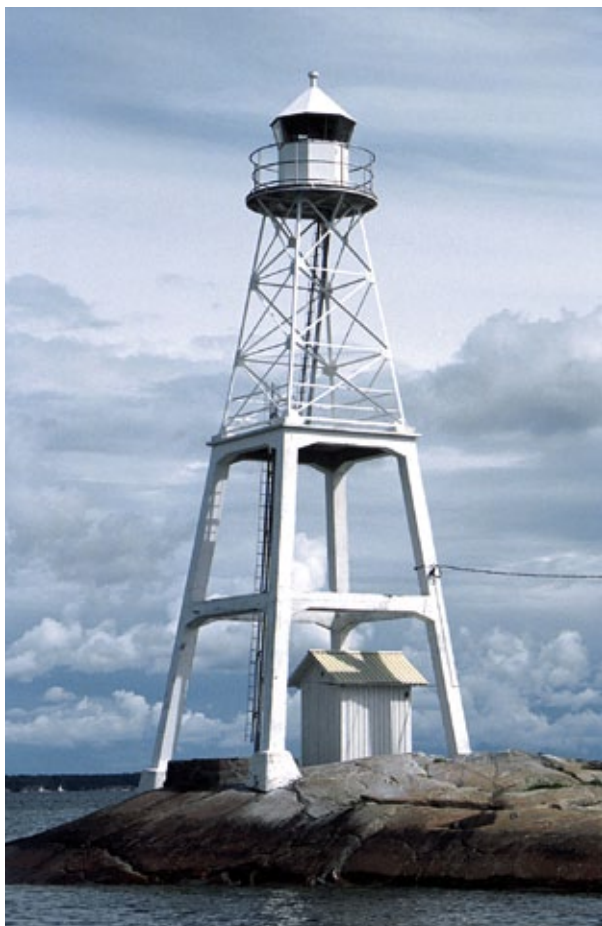
Orhisaaren loisto Airiston selän eteläpäässä on korotettu nykyiseen asuunsa 1930-luvulla. Ensimmäisen vaiheen graniittiperustus – loiston perustamisvuodelta 1903 – näkyy jalustan betonianturoiden välissä polttoainekopin edessä.
