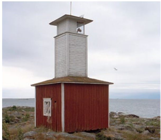
Rövargrundin kalastusloiston alakerrassa on lämmitettävä majoitushuone loistonhoitajan tarpeisiin.
