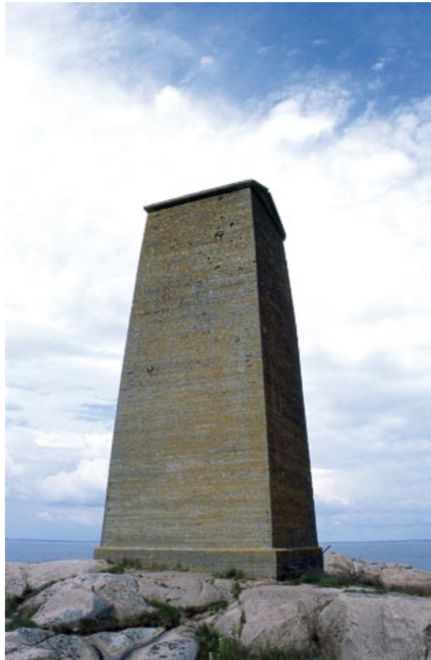
Segelskärin tunnusmajakka on rakennettu teräsbetonista, korkeus maanpinnasta 13,4 metriä.
