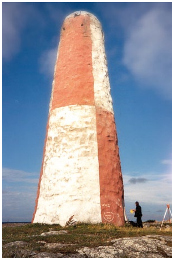
Lyökin jyhkeäseinäinen kivipooki vuodelta 1756 on ontto. Yläsanteelle voitiin tarpeen vaatiessa sytyttää lyhty. Valo tuikki mustana erottuvista läpirei'istä.
