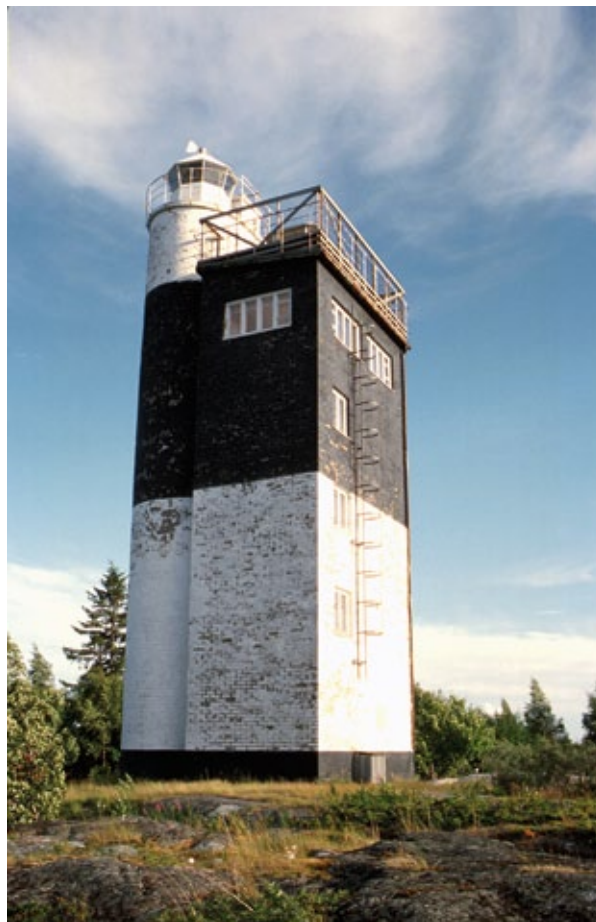
Stubbenin saariryhmään kuuluvalla Lillskärielle rakennettiin yhdistetty majakka- ja luotsiasemarakennus vuonna 1954.
