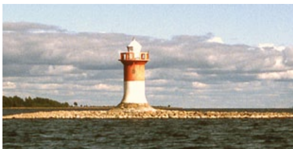
Kraasukanletton loiston jalusta on muotoiltu kestäväksi jätien kuluusta.
