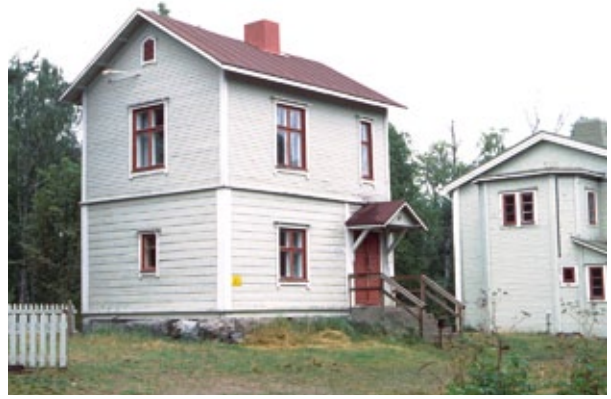
Iin Röytän luotsivartiotupa, oikealla näkyy satamassa työskennelleitten ahtaajien asuntolarakennuksen pääty.
