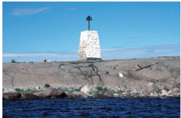
Vuonna 1905 valmistunut Rönnskärin merimerkki edustaa kummelirakentamisen huipentumaa. Vielä samalla vuosikymmenellä saaristoväylien perusmerkiksi vakiintui rautaiseen suojakoppiin sijoitettu johtoloisto ja kivekkummeleitten rakentamisesta luovuttiin.
