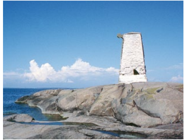
Tammisaaren Storgaddenin tunnusmajakka vuodelta 1933 edustaa myöhäistä tunnusmajakkarakentamista. Yläkulmassa erottuva ”käsivarsi” osoittaa, miltä puolelta luoto on turvallista ohittaa.
