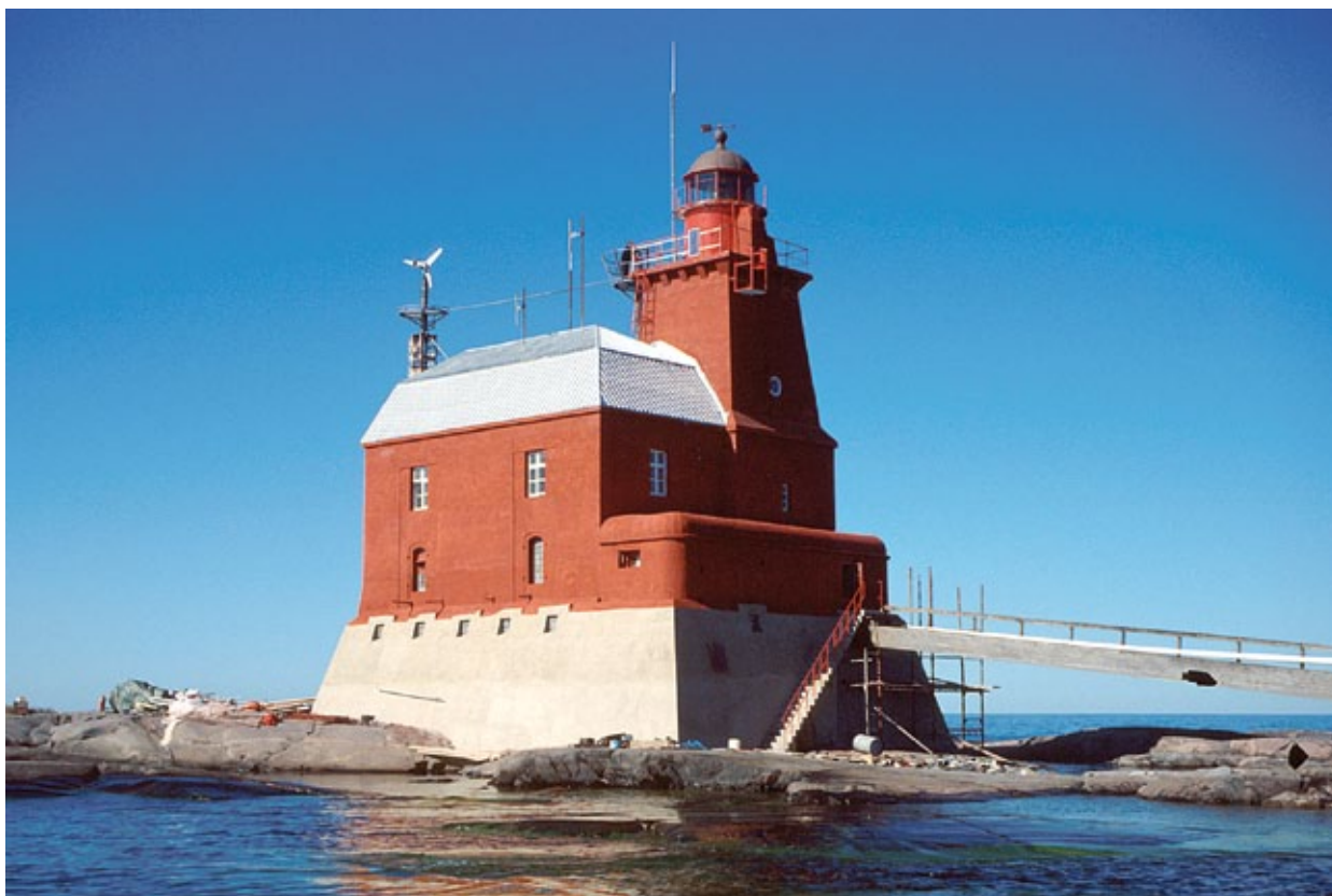
Kallbådan majakka vuodelta 1920 on Suomen viimeinen miehitetyksi rakennettu majakka. Rakennuskompositio on vaativien luonnonolojen vuoksi poikkeuksellinen. Majakkatorni ja henkilökunnan asuintilat sijoittuvat samaan rakennukseen.
