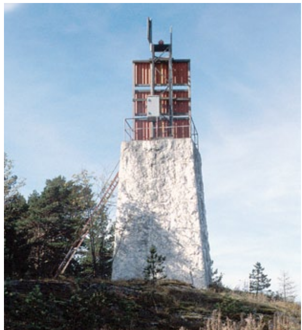
Gråskärin kivitorni on Suomen kookkain kummelityyppinen merimerkki. Nykyisin sen päällä on myös loistolla varustettu linjataulu.
