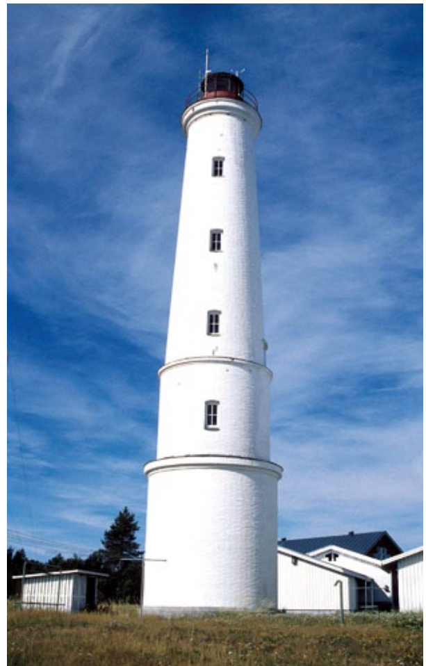
Marjaniemen majakka on säilyttänyt siron, klassista pylvästä tavoittelevan hahmonsä. Useimpien muiden tiilimajakoiden ympärille on myöhemmin valettu tornia tukeva betonimantteli.
