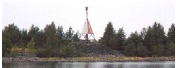
Kriisin rökkiökummeli on alun perin vuodelta 1874, sitä on korostettu puisella huippumerkillä ja edelleen pimeänavigoinnin mahdollistavalla loistolla.
