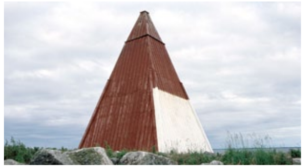
Enstenin tunnusmajakka on 16,8 metriä korkea lautavuorattu hirsipyramidi, sen harkittu muoto soveltui hyvin vaativiin avomeriolosuhteisiin.
