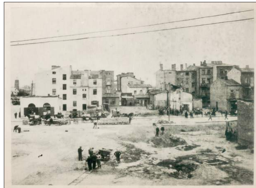
Ryc. 29. Kolejka tymczasowa wykorzystywana do prac rozbiórkowych w centrum Sochaczewa, 1939/1940 r. (źródło: zbiory Zespołu Szkół Centrum Kształcenia Praktycznego w Sochaczewie).
