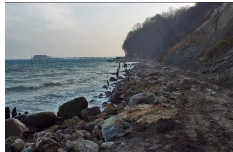
Ryc. 22. Pozostałości estakady, na której położono tor łączący Wąwóz Ostrowicki z portem na Oksywiu (fot. Autor, jesień 2015 r.).
