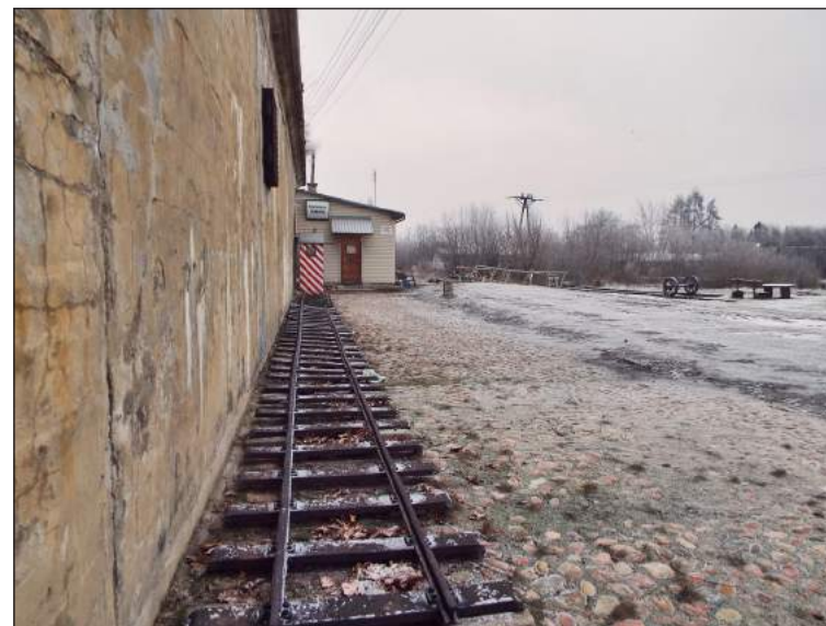
Ryc. 25. Zachowane przęsła torowe na 600 i 750 mm na terenie Prochowni Terespol w Twierdzy Brześć (fot. Autor, zima 2016 r.).
