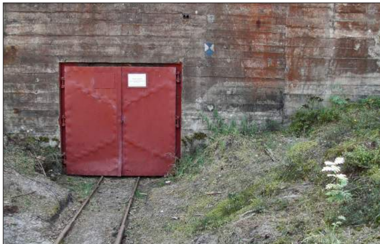
Ryc. 29. Dawny schron niemieckiej baterii artylerii najcięższej na Helu wykorzystywany do początku XXI w. przez Marynarkę Wojenną w roli magazynu. Widoczny tor kolejki (fot. Autor, lato 2009 r.).
