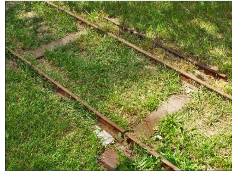
Ryc. 30. Pochodzący z Poligonu Rembertowskiego fragment prześła torowego o prześwicie 600/750 mm. Obecnie wykorzystany w prywatnej kolei ogrodowej (fot. Autor, lato 2014 r.).
