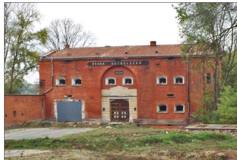
Ryc. 20. Twierdza Modlin, Brama Ostrołęcka – kolej pokonywała ją przebiegiem widocznym z lewej strony (fot. Autor, jesień 2019 r.).
