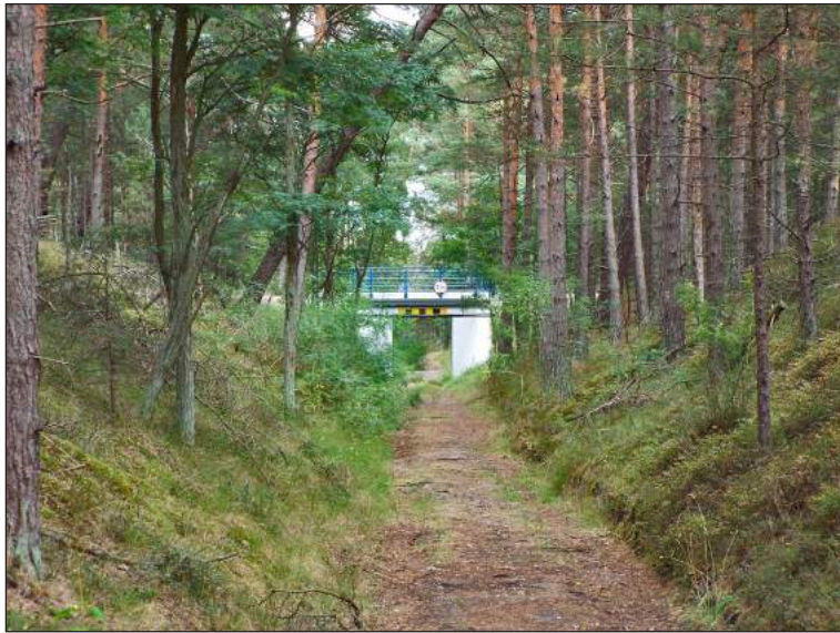
Ryc. 35. Fragment rozebranej linii kolejki wąskotorowej w kierunku cypla helskiego. W tle widoczny wiadukt linii normalnotorowej Puck–Hel (fot. Autor, lato 2016 r.).
