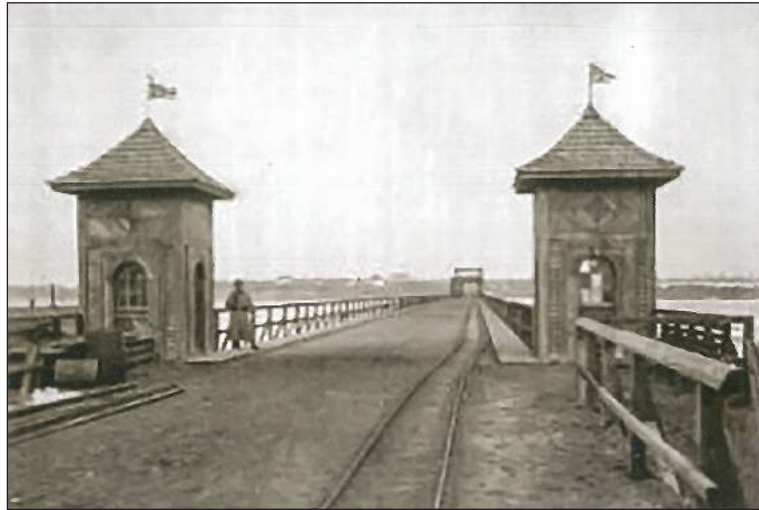
Ryc. 10. Tor kolei Ruszki–Młodzieszyn–Kamion–Wyszogród biegnący przez most na Wiśle w Wyszogrodzie, 1916–1918 r. (źródło: M. Mistewicz, dz. cyt., s. 127).
