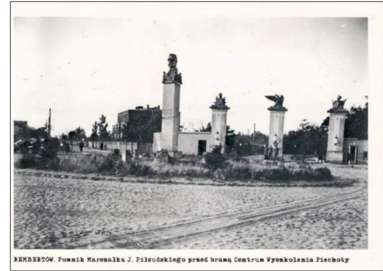
Ryc. 29. Brama do Centrum Wyszkożenia Piechoty w Rembertowie z widocznym torowiskiem kolei poligonowej o prześwicie 750 mm (źródło: www.kasikkrysyk.blogspot.pl ).
