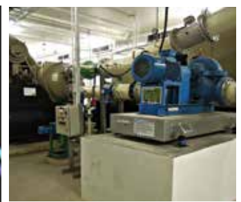
Gambar 40. Sistem yang Sudah Diinstalasi
