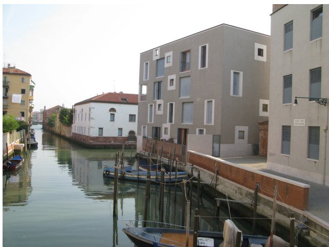
Edificio Residenziale D Giudecca, Venetsia, Italia
