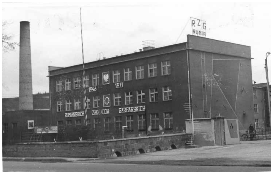
Nieistniejący już budynek Rumiańskich Zakładów Garbarskich „Rugar”. Zdjęcie z 1971 roku
