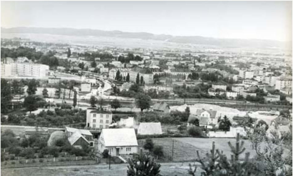
Panorama Rumi 1971 rok. Na pierwszym planie budowa wiaduktu
