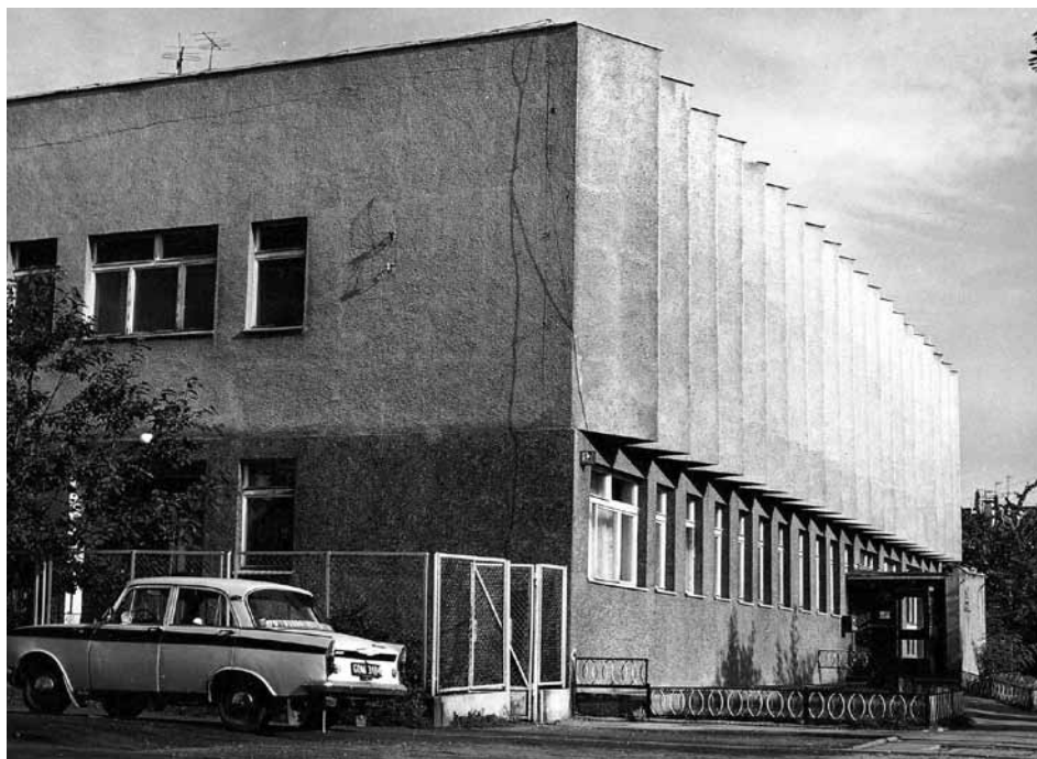
Budynek poczty przy ulicy Starowiejskiej. Lata siedemdziesiąte
