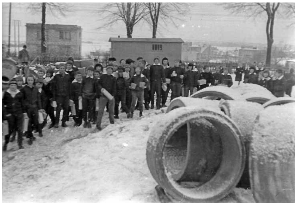
Uczniowie pomagają przy budowie pawilonu przy Szkole Podstawowej nr 3 – 1966 rok
