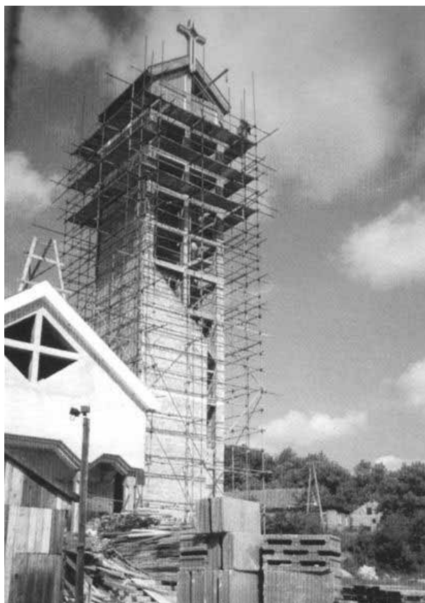
Budowa wieży kościelnej – 1989 rok
