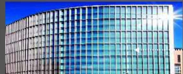
struktur dinding Menggunakan glas panel
