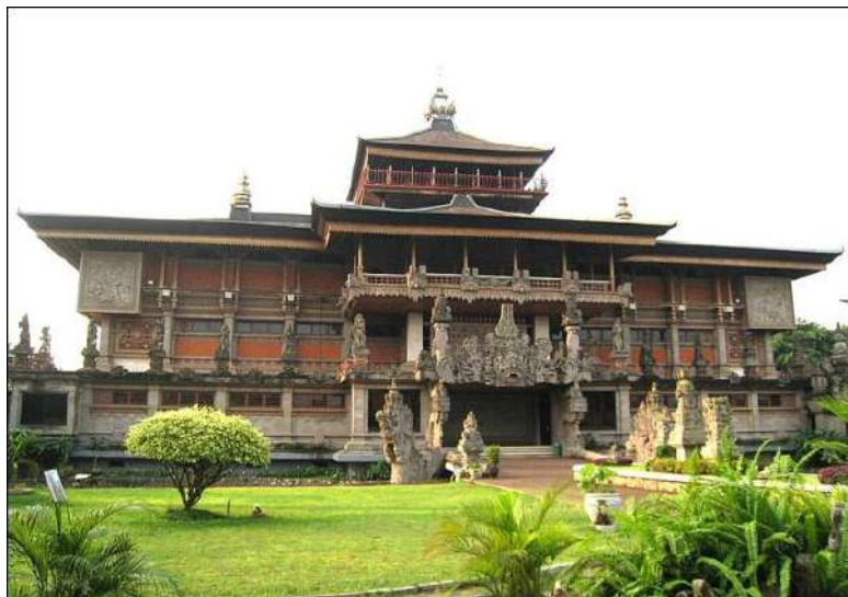
Gambar II.16. bangunan utama museum indonesia
