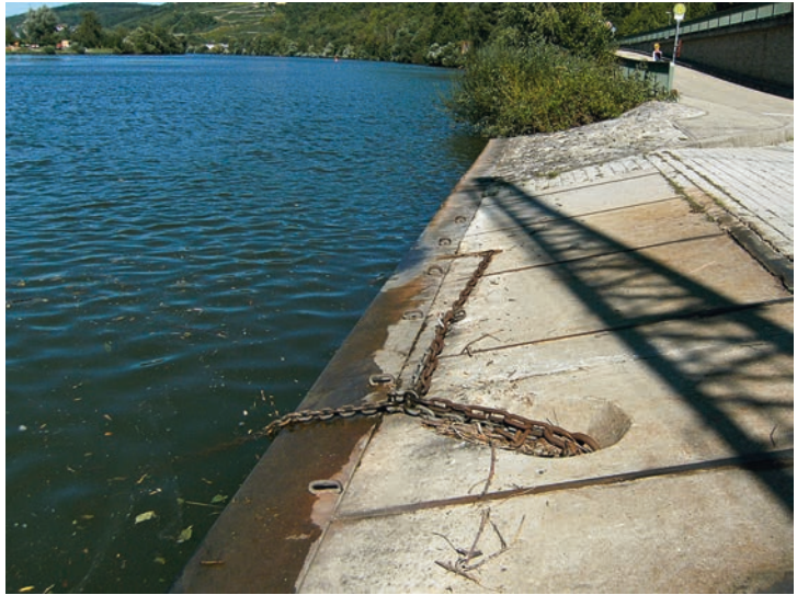
Verankerung der Kette in der Betonplatte der Zufahrtsrampe. Rechts im Bild der Schatten des Gittermastes für die Elektroberleitung der Fähre (Foto: Otto E. Hofmann)
