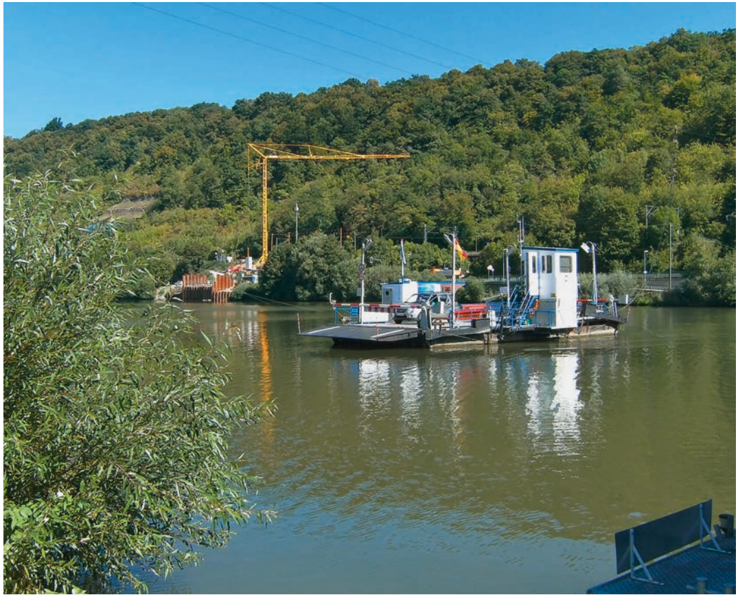
Kettenfähre über den Neckar in Haßmersheim. Links Baukran der Baustelle für den neuen Neckarsteg. September 2013 (Foto: Otto E. Hofmann)
