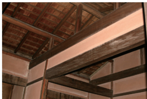
写真6 地震殿の天井
