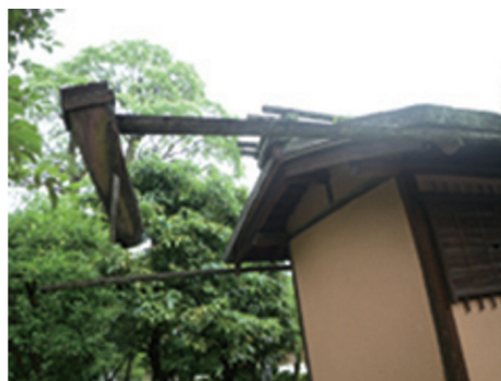
写真8 地震殿の御厠から突き出ている樋。
