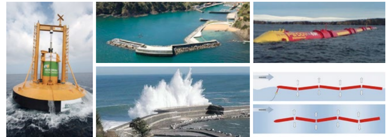
Figura 1. Tres métodos en desarrollo para transformar la energía de las olas en energía eléctrica: De izquierda a derecha: Boya de Iberdrola en Santoña (Cantabria), Central Undimotriz tipo OWC de Mutriku (Euskadi) y Pelamis instalado en Escocia (Pelamis aprovecha el movimiento vertical y lateral).
