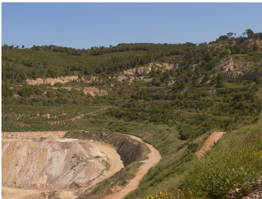
FIGURA 10. Restauracions a la pedrera de calcària de Vallcarca. Els talussos de la part superior marquen el límit de la pedrera. Foto presa el 2009.
