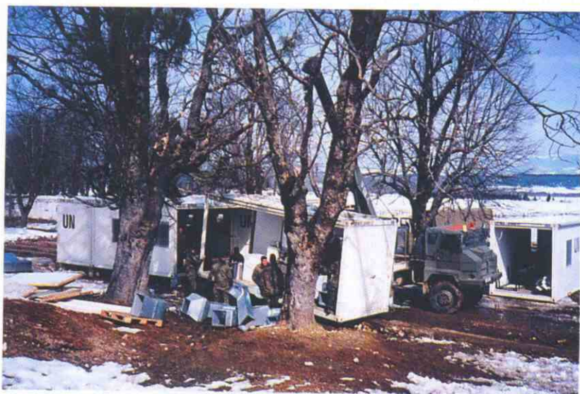
La cocina-comedor permanece esperando que disminuya la nieve y los ingenieros puedan venir a montarla y ponerla en servicio.
