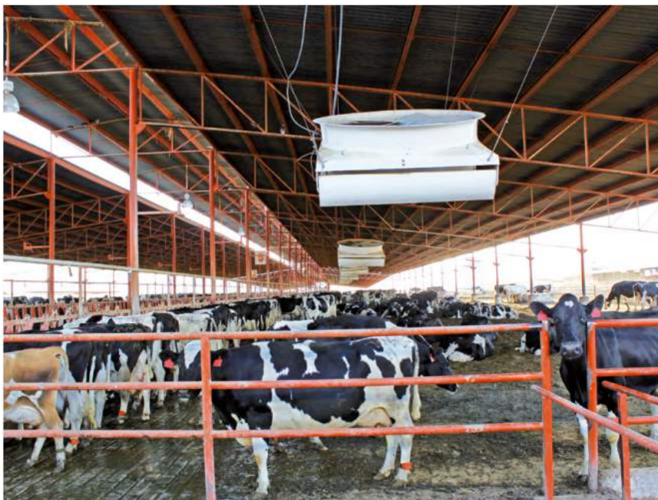
Figura 11: Currais com ventiladores instalados no teto (ventilação forçada). Arquivo pessoal do autor.
