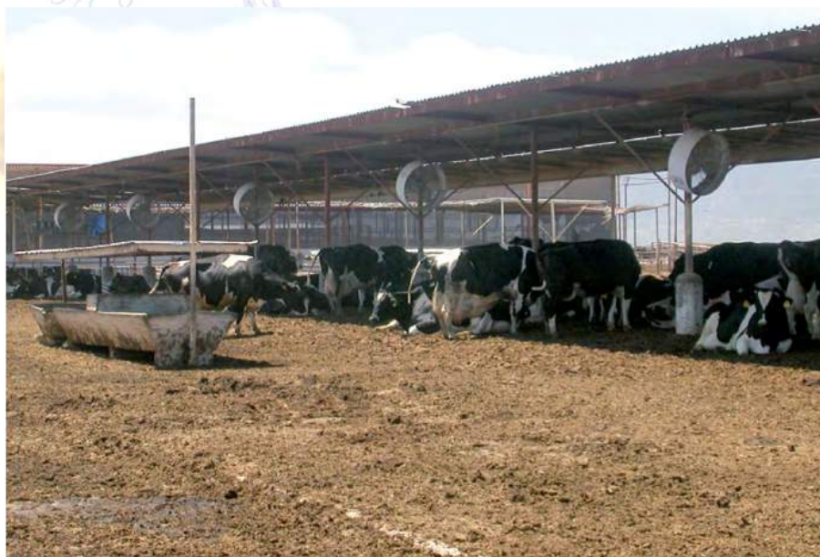
Figura 15: Instalações com refrescamento por aspersão e ventilação forçada em condições semiáridas. Arquivo pessoal do autor.
