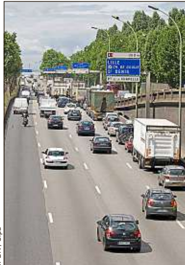
Le boulevard périphérique au niveau de la porte d'Aubervilliers.
