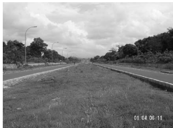
Gambar 2.4.14 Jalan Akses Terminal Baru
