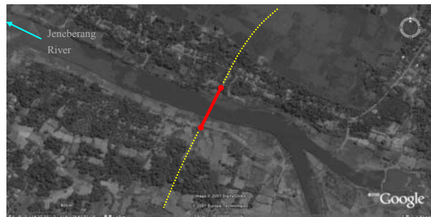
Gambar 7.19 Jembatan Jeneberang No.1 pada Mamminasa Bypass
