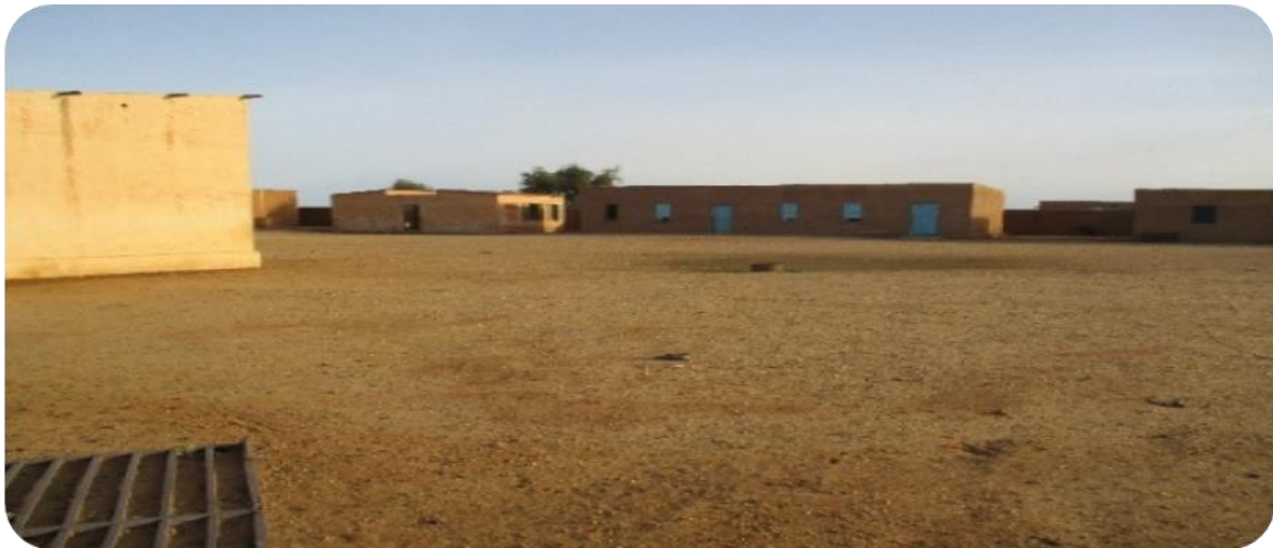
Photo 2 : École I de Kiffa nécessitant une réhabilitation
