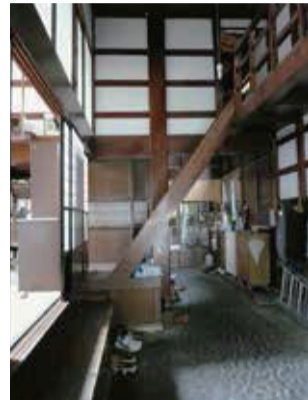
トオリドマ上部の渡り廊下に架かる階段
