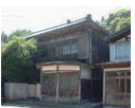
⑦ 旧岩間医院 昭和初期の建物で、かつては医院でした。特徴的な八角形の玄関やその柱、せがいで、前庭等があり、細部まで凝った造りが見られる建物です。
