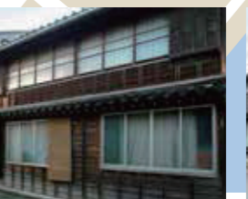
⑱ 重四郎 かつて材木を扱う仕事を営んでいました。せがいで、ガラス雨戸が見られ、矢羽根模様の戸袋が建物の両端に付いています。
