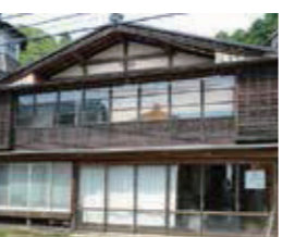
⑬ 旧東屋旅館 大正期の町屋でかつては旅館を営んでいました。建物の両端に付く戸袋と窓付き雨戸が見られ、間口が大きく二階の張り出しと一本の丸太を使った下屋がある建物です。
