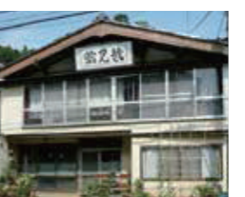
⑮ 旧越見館 かつて旅館を営んでいました。建設当時からある越見館の看板と、二階の窓の内側に欄干が見られます。二階の張り出しと下屋がある町屋です。
