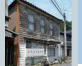
⑩ 旧前佐渡(まえさど)水電 大正9(1920)年の建物で、かつては電力会社でした。洋風下見板や縦長の上げ下げ窓が見られ、赤泊では珍しい洋館です。
