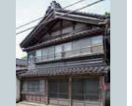
⑨ 森川 かつては呉服店を営んでいました。戸袋にある森川の屋号の文字と、屋根の上の明かり取り、二階の張り出しと下屋が見られる町屋です。
