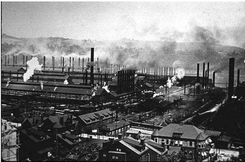
L'acciaiera " Homestead Steel Works " di Homestead PA vicino Braddock PA
