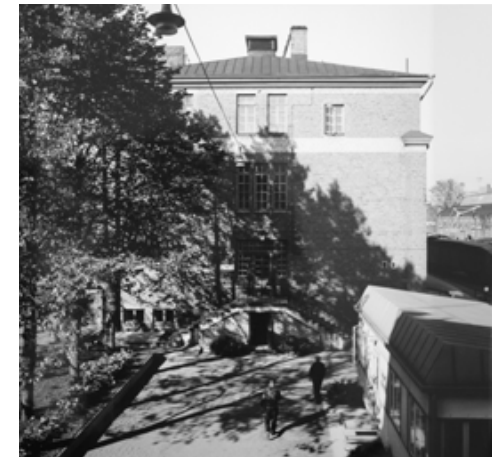
Vuosina 1906-1926 Rautatiehallituksessa toimi useita suunnittelijoita Bruno F. Granholmin johdolla. Rakennustekniikassa siirryttiin enenevästi teräsbetonirakenteiden käyttöön. Pasilan konepajan Ruokala ja oppilaskoulu, Thure Hellström 1921. (Kuva: Suomen Rautatiemuseo / O. Karasjoki.)
