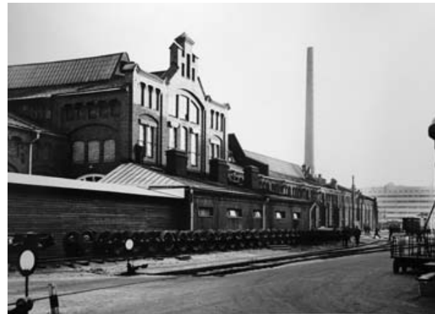
Pasilan konepajan perustamisvaihe 1900-luvun alussa kuuluu arkkitehti Bruno F. Granholmin aktiivikauteen. Työpajarakennusten pohjapinta-ala kasvoi, ja kattovaloratkaisut ja teräksiset kattotuolirakenteet kehittivät. Pasilan konepajan kokoonpanohalli, Bruno F. Granholm 1901. (Kuva: Suomen Rautatiemuseo / O. Karasjoki.)
