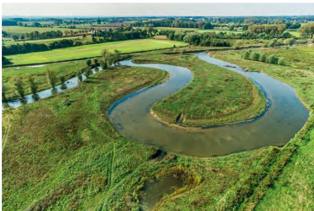
Abbildung 22: Eine neue Schleife der Lippe in der Westernmersch 2015 (Quelle: ABU).
