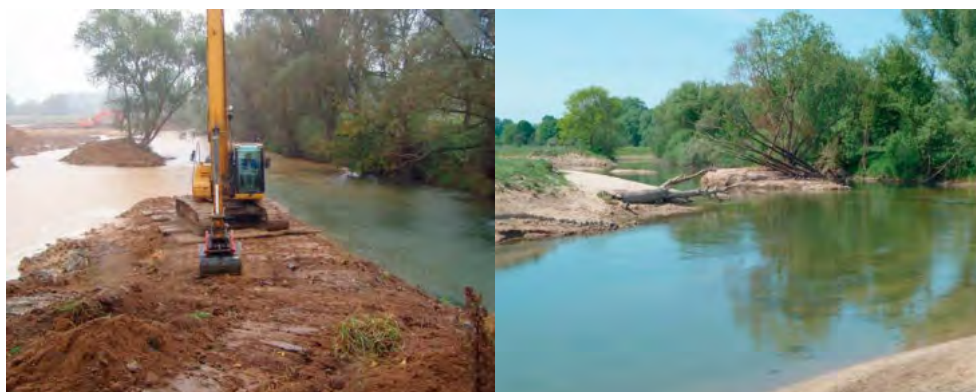
Abbildung 21: Bauarbeiten in der Lusebredde westlich von Lippstadt (links) und die Lippe in der Lusebredde nach dem Umbau (rechts, Quelle: ABU).
