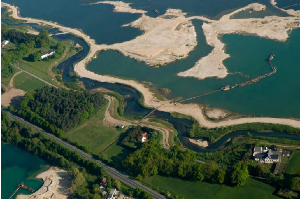
Abbildung 13: Luftaufnahme der Lippeseumflut (Quelle: NZO).
