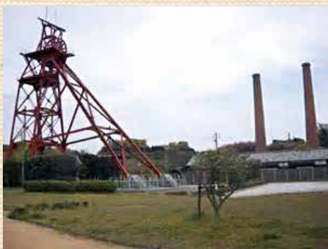
旧三井田川鉱業所の伊田堅坑槽、第一・第二煙突
