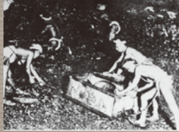
切羽における採炭作業 (明治時代の人力採炭) (九州歴史資料館所蔵 筑豊工業高校資料)
