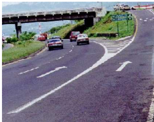
Fotografía 4.7 Extremo de isla con demarcación gradualmente ensanchada.
