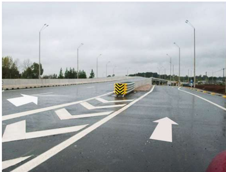
Fotografía 4.8 Amortiguador terminal para barrera de seguridad
