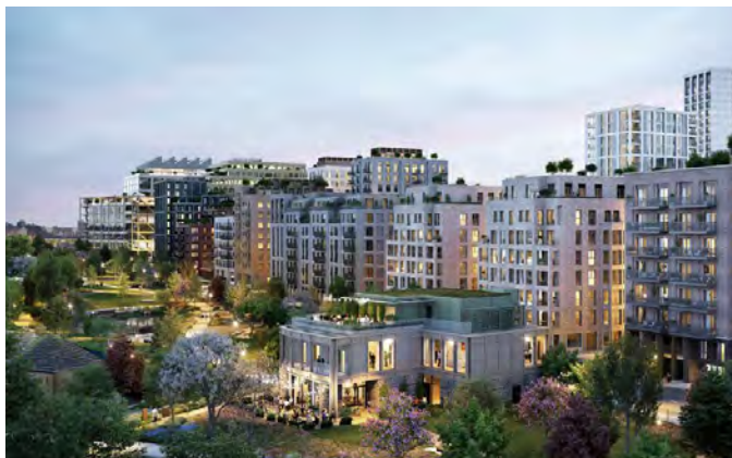
Brent Cross South - Vattenfalls första fjärrvärmenät i Storbritannien.
