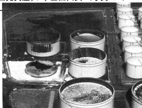
出光興産タンク全面火災 (写真No.4)
