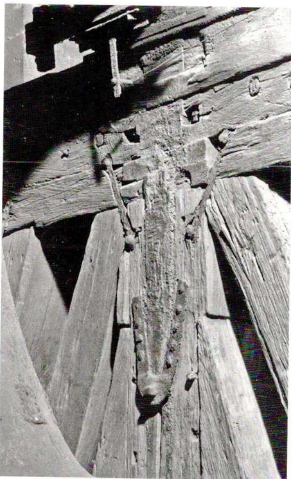
Abb. 23: Rest eines Stelzenlagers an der nördlichen Stuhlwand der großen Glocke. (Photo: C. Peter).
