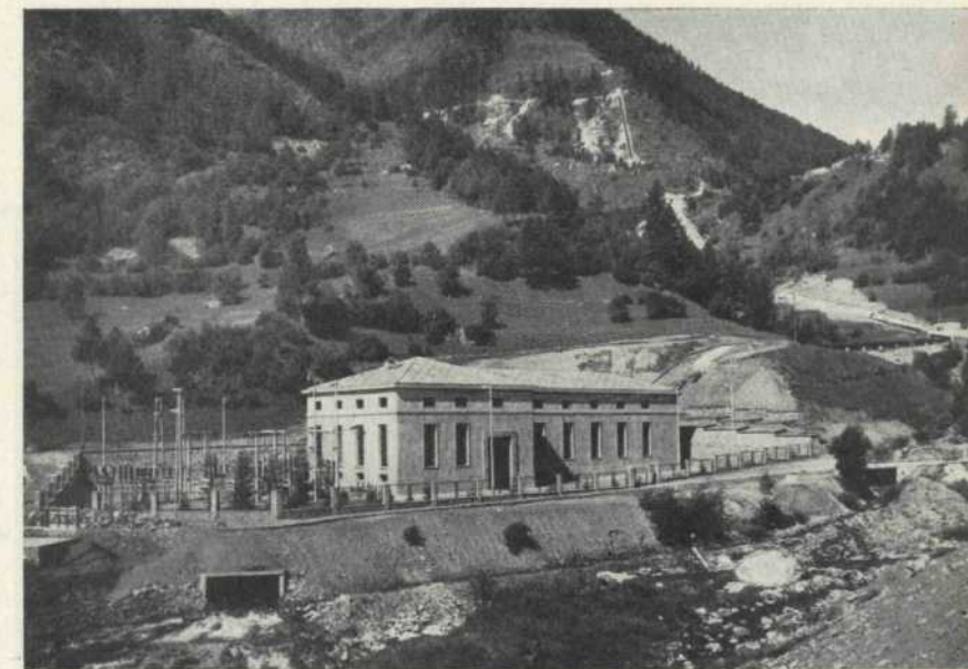
Fig. 9. - Centrale di Fenestrelle e condotta forzata.
