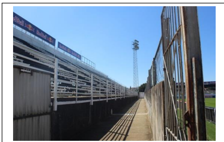
FOTO 252: ATERRAMENTO DAS GRADES JUNTO AO CAMPO
