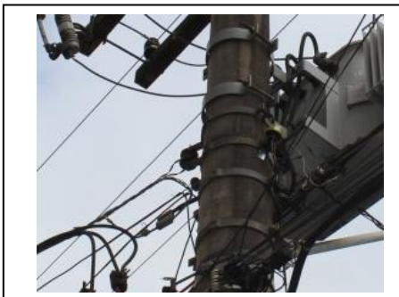
FOTO 106: FERRAGENS EM BOAS CONDIÇÕES DE FIXAÇÃO. Administração e Torre 3-4
