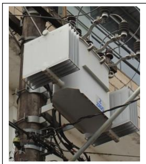
FOTO 107: FERRAGENS EM BOAS CONDIÇÕES DE FIXAÇÃO. Administração e Torre 3-4
