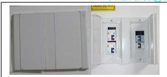
FOTOS 153 A 154: QFL2 – CHUVEIROS - VESTIÁRIO LOCAL
