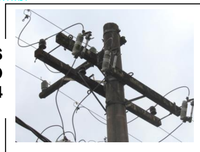
FOTOS 102: CRUZETAS EM BOAS CONDIÇÕES DE INSTALAÇÃO Administração e Torre 3-4
