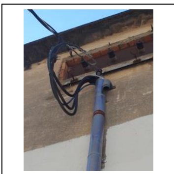
FOTO 132: ENTRADA DOS CABOS SUBTERRÂNEOS. Torre de Iluminação 1 e 2
