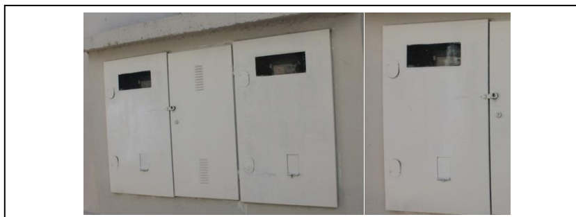
FOTOS 139 E 140: ESTRUTURA EM BOAS CONDIÇÕES Quadro de Medição Entrada 2 – Alojamentos
