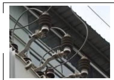
FOTO 105: PARA RAIOS POLIMÉRICOS EM BOAS CONDIÇÕES. Administração e Torre 3-4
