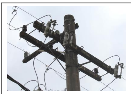
FOTO 105: PARA RAIOS POLIMÉRICOS EM BOAS CONDIÇÕES. Administração e Torre 3-4
