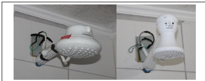
FOTOS 203 E 204: CHUVEIROS - VESTIÁRIO DOS ÁRBITROS
