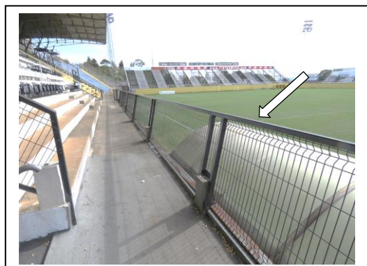
FOTOS 2A / 2B: GUARDA-CORPOS FRONTAL E CORRIMÃO
