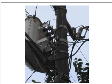
FOTO 122: FERRAGENS EM BOAS CONDIÇÕES DE FIXAÇÃO. Restaurante e Vestiário Local
