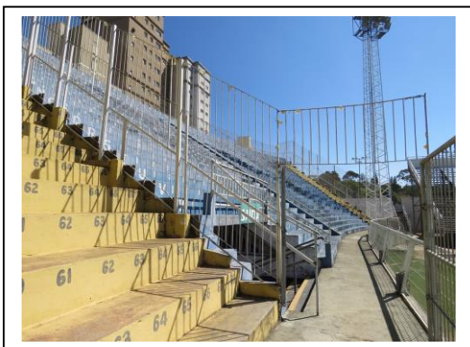
FOTOS 10A / 10B / 10C / 10D: GUARDA-CORPO FRONTAL, CORRIMÃO E GRADIS DE DIVISÃO
