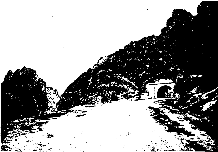
Fig. 3. — Le tunnel routier d'El Gueria (côté Est)
