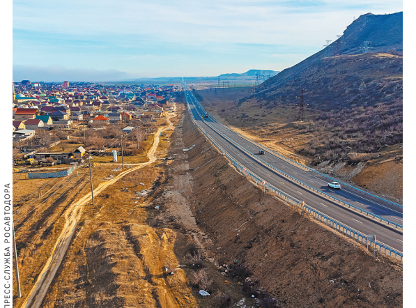
На дороге Р-217 «Кавказ» развернуты масштабные работы по расширению трассы до четырех полос.
