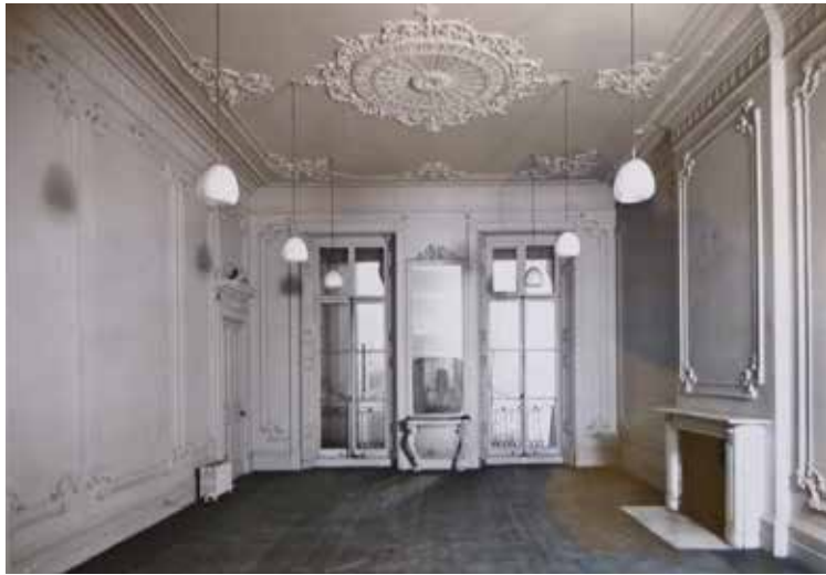
Roter Saal während der Bauarbeiten und nach der Fertigstellung Red Room under renovation and today
