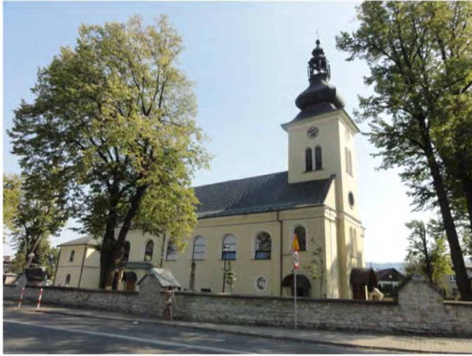
Kościół p.w. Nawiedzenia NMP w Hałcnowie
