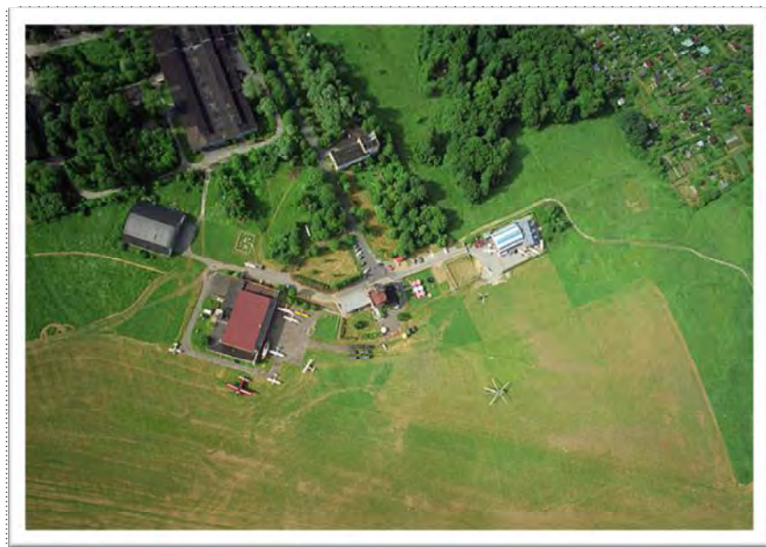
Kompleks budynków lotniska
