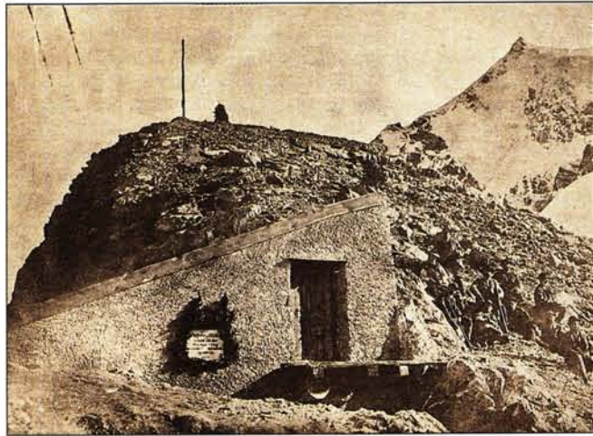
Payerhütte (3020 m). Nach Stüdl's Initiative und Planung errichtete die Sektion Prag den Urbau dieser Hütte 1875 und schuf damit den bis dahin höchstgelegenen Stützpunkt der Ostalpen zur Besteigung des Ortlers, damals höchster Berg Österreichs. Die Hütte bot 16 Touristen Nüchtmöglichkeit. Ein einziger Raum diente zugleich als Küche, Gaststube und Nachtlager. Später wurde die Payerhütte mehrmals vergrössert; sie bildete bis zum Ende des 1. Weltkriegs den stattlichsten Hüttenbau der Sektion Prag. Die Payerhütte wurde - wie alle Hütten des DuOeAV in Südtirol - vom italienischen Staat enteignet. Heute verwaltet sie die Sektion Mailand des CAI.
