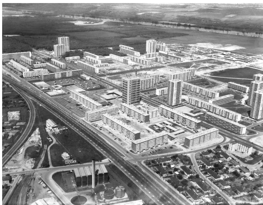
Val Fourré, vue aérienne avec la voie de chemin de fer en premier plan, 1968 © Claude Bertin, Ville de Mantes-la-Jolie
