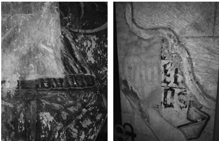
Limpeza mecánica - eliminación de eflorescencias salinas, velos de cal e po
