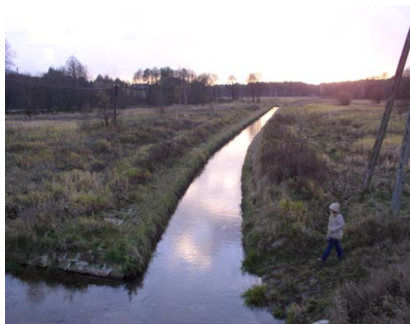
Ujednolicenie koryta Krztyni spowodowało zmniejszenie ilości, różnorodności i biomasy ryb.
