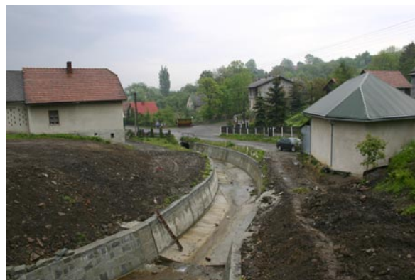
Wprowadzenie Wieśnika w betonowy łob będzie skutkowało istotnym wzrostem zagrożeń powodziowych.
