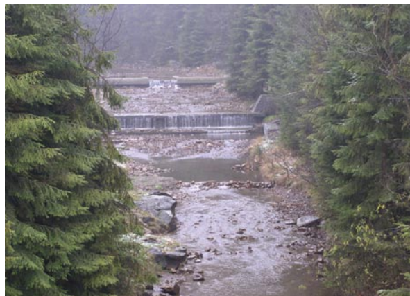
Wyremontowane stopnie na Białej Wiselce.
