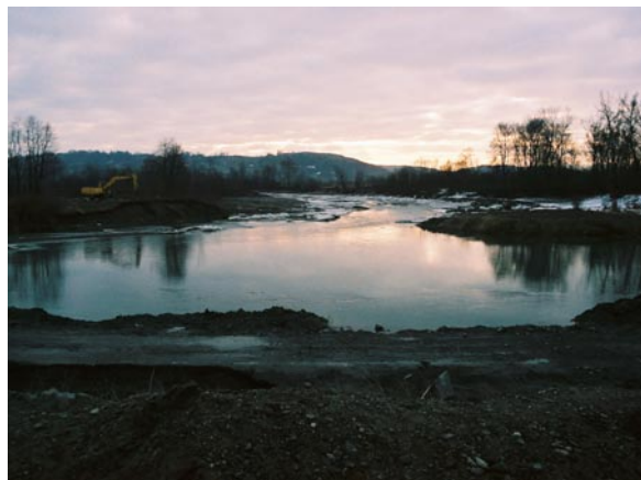
Prace regulacyjne nad Stradomką w 2002 roku.
