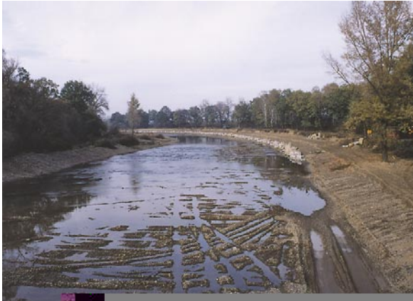
Regulacje średnich rzek polegają zazwyczaj na zawężeniu i ujednoliceniu ich koryta oraz zabudowie brzegów kamieniem.
