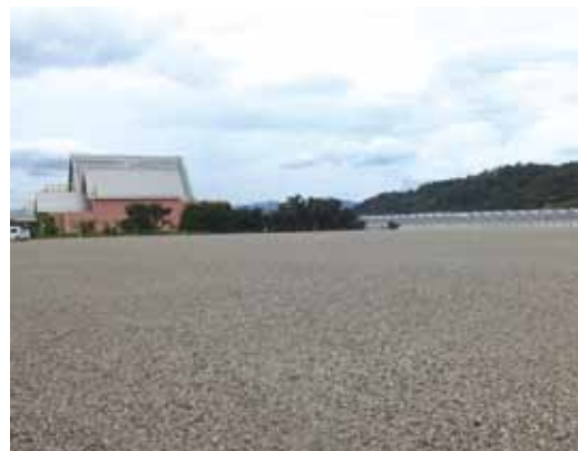
連棟ハウス予定地
