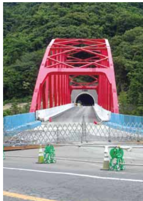
音海トンネル・橋梁 音海中津海線工事
