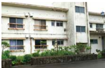
中町広場前の住宅
