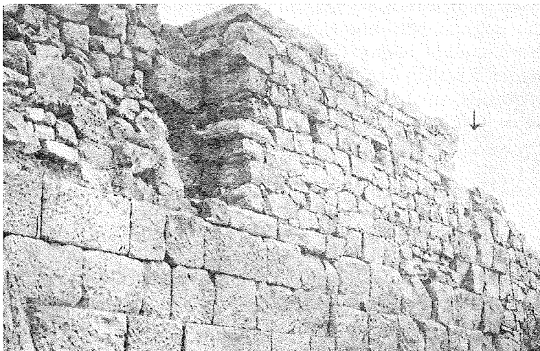
Fig. 14 - Sett. B dopo il restauro conservativo. Il delfino \alpha risulta arretrato dalla fronte. Il delf. \beta in asse alla freccia.
