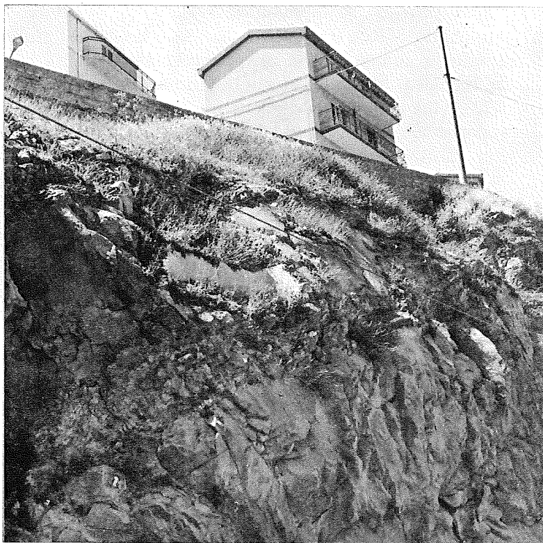
Fig. 17 - Versante nord di Scalforio, cisterna
