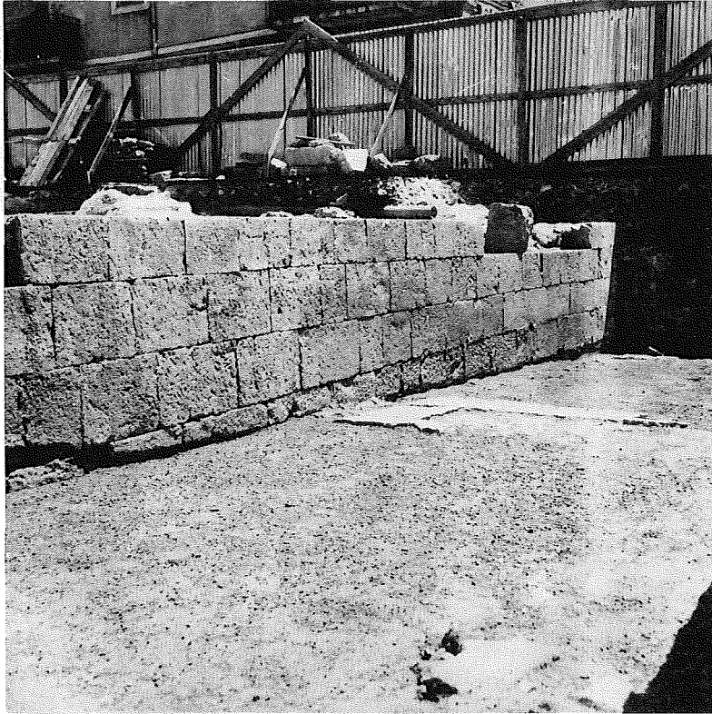
Fig. 1 - Il «muro H»: a destra si intravede lo stipite della porta.
