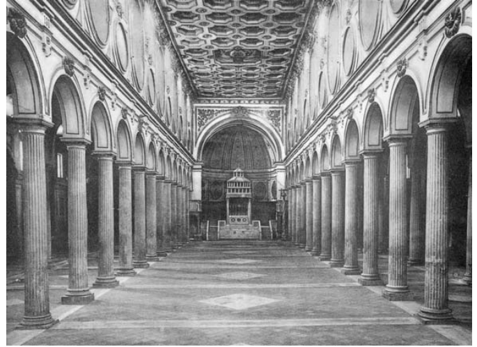
Fig. 108. Duomo, navata centrale prima dei bombardamenti del 1943
