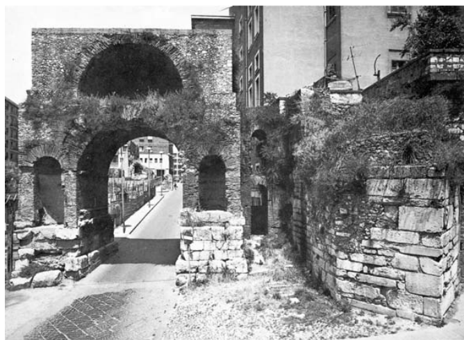
Fig. 93. Arco del Sacramento e torre pentagonale di V secolo
