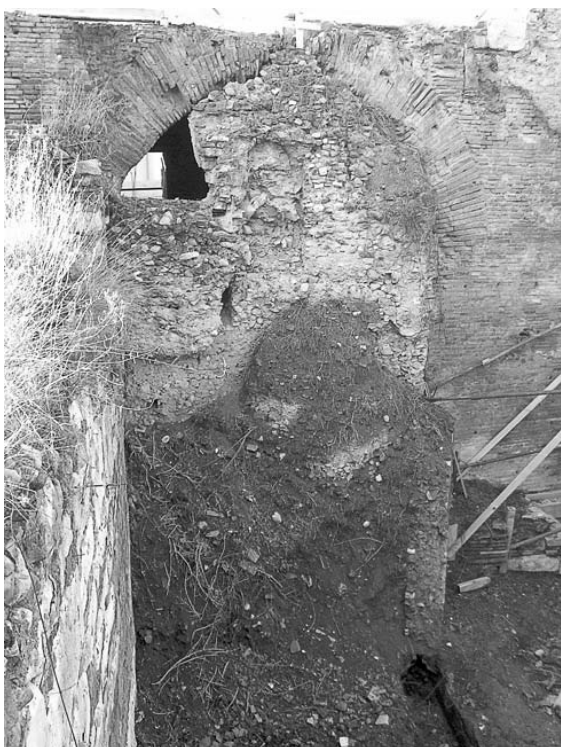
Fig. 103. Area dell'arco del Sacramento, arco 2000, particolare della tamponatura
