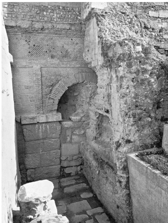
Fig. 99. Rocca dei Rettori, arcata di un acquedotto romano inglobata dal fortilizio che muniva porta Somma
