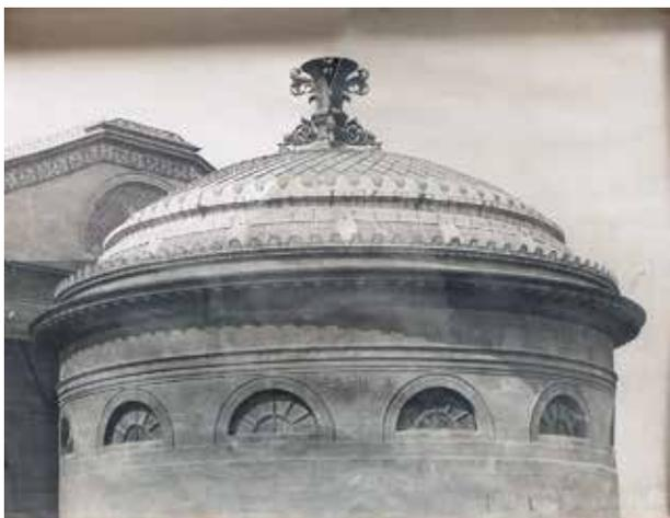
colari. La cupola è caratterizzata da un complesso di sedici arconi radiali, cinque anelli poligonali e centoventotto diagonali che ne rendono possibile il sostegno. A coronamento della struttura è posto
