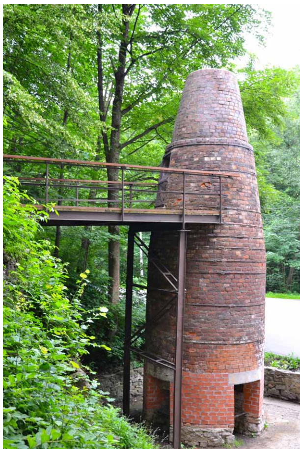
Wyższy wapiennik, widoczny podest do zasypywania surowca
