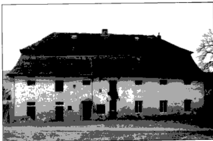
Seč, obytná budova v bývalém panském dvoře, pohled z někdejšího nádvoří (foto A. Monhartová 2002)
