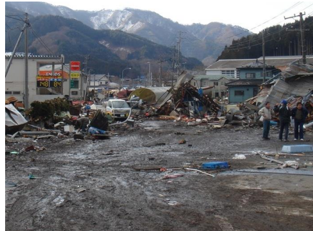
国道 45 号 釜石市
