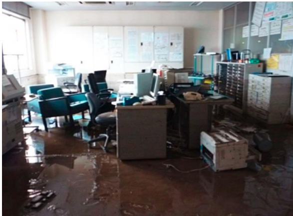
仙台港北 I C 料金所事務室浸水状況
