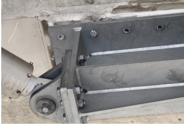
国道 13 号 福島西道路泉高架橋
