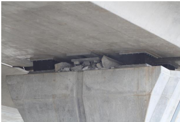
国道 13 号 福島西道路吾妻高架橋
