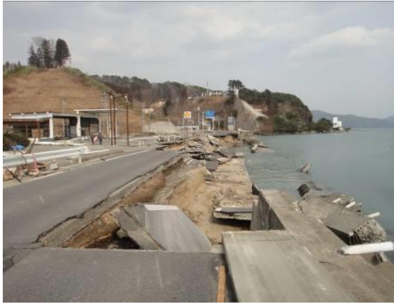
国道 45 号 山田町
