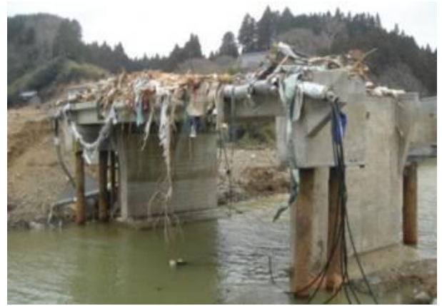
国道 45 号 気仙沼市 二十一浜橋
