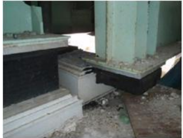
仙台東部道路 仙台東 IC～仙台港北 IC 仙台東部高架橋
