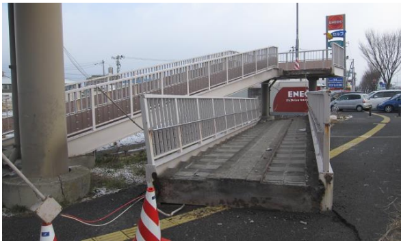
国道4号 霞目歩道橋
