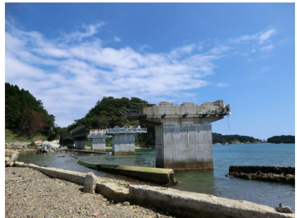
国道 45 号 南三陸町 歌津大橋
