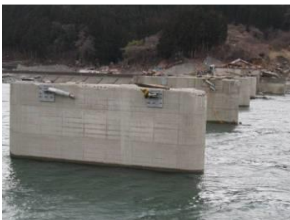
国道 45 号 陸前高田市 気仙大橋
