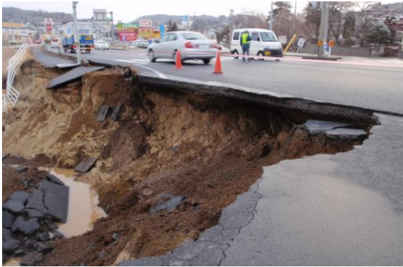
国道4号 栗原市築館
