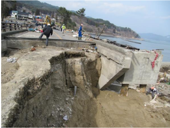
国道 45 号 大槌町 波板橋
