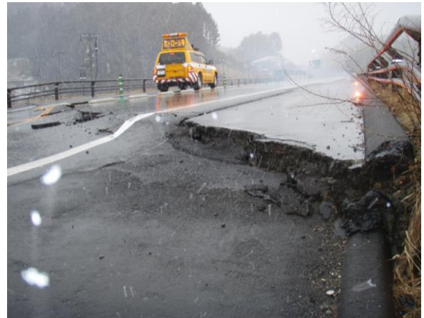
三陸自動車道 東松島市
