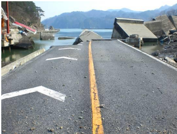
国道 45 号 釜石市
