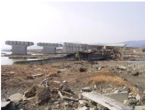
国道 45 号 陸前高田市 沼田跨線橋
