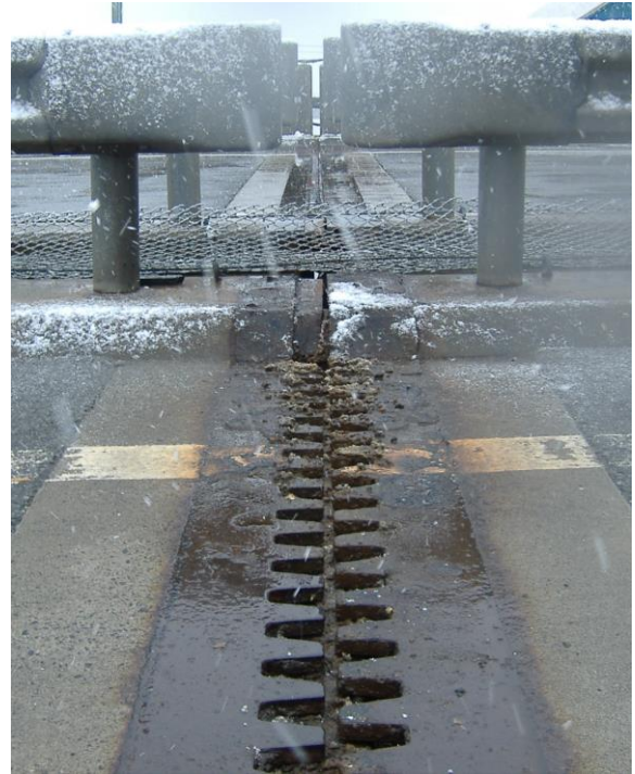
国道 45 号 鳴瀬大橋
