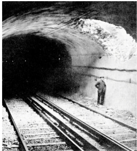
Une bombe a percé la chaussée sous laquelle le métropolitain est aménagé. (L'illustration 1916).
